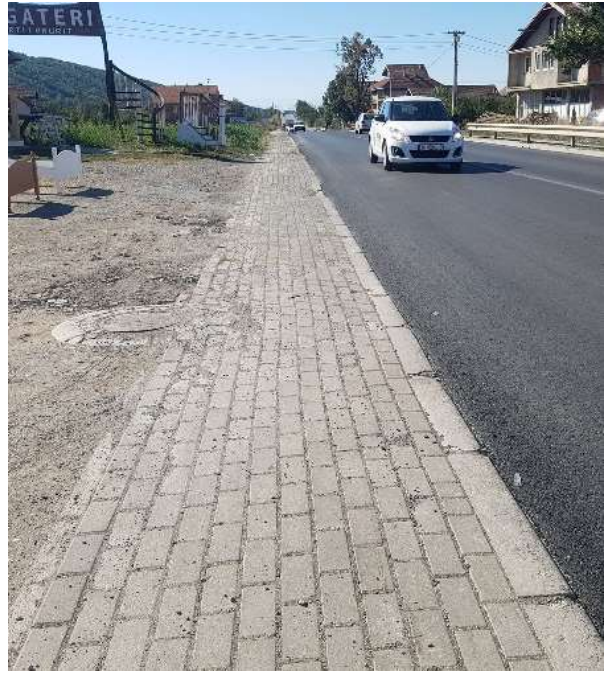
Fig.25. Niveli i njëjtë i trotuarit me pjesën e rrugës
