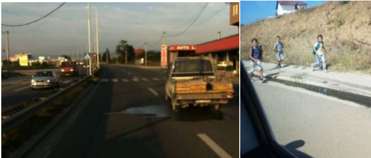
Fig.23. Mungesa e nënkalimeve/mbikalimeve në pjesët e rrugëve nacionale të cilat kalojnë nëpër zona urbane
