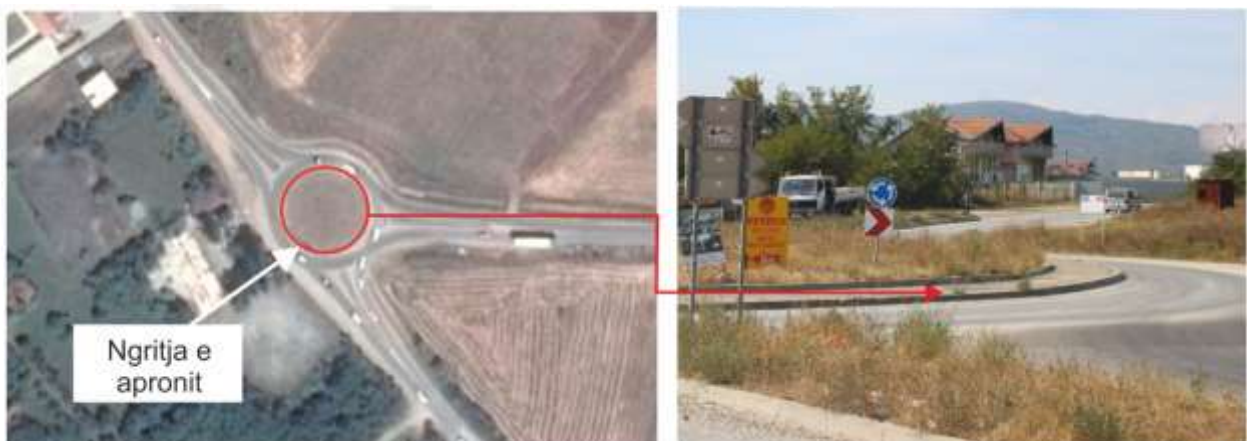
Fig.11. Rasti i evidentuar në të cilin aproni është ngritur në nivel të trotuarit
